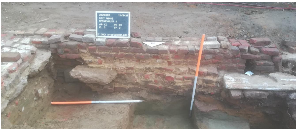
Figuur 30. Profielpit PP4 werd gegraven in de zuidoostelijke hoek van de stal. We zien de westmuur (S3) van de stal, die gebruik maakt van een oudere fundering (S29) met gele mortel. De uitholling was wellicht het resultaat van het proberen incorporeren van de 'nieuwe' oostmuur (links) in een bestaande structuur.
