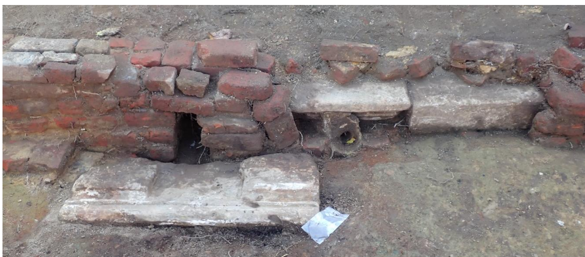
Figuur 28. Rechthoekig gat in de zuidmuur (S3) van de stal, waardoor de ontlasting van de koeien kon worden afgevoerd. Een kleiner, rond gat rechts daarvan betrof een latere interventie (moderne cement), mogelijk voor de aanvoer van water om de vloer schoon te vegen. Voor de drempel en het eindpunt van de goot werden stukken bewerkte natuursteen van wellicht ter plaatse afgebroken structuren hergebruikt.
